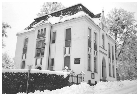
Sborová budova po generální opravě, rok 1993.
